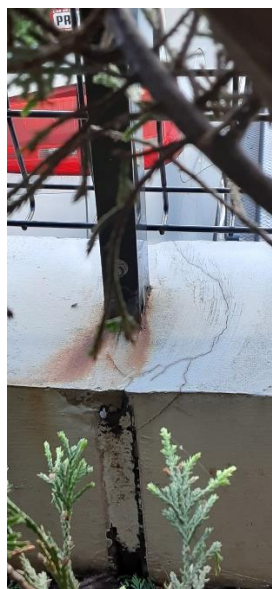
駐車場裏の柵
