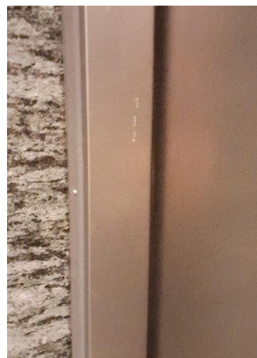
E 棟 1 階エレベータドア枠
