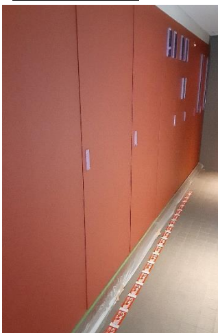
E 棟電源設備下地塗装後
