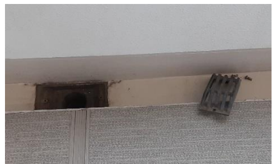
共通廊下排水溝。蓋を外して塗装(重要)
