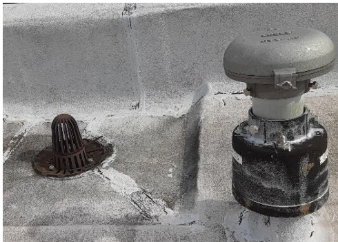
5 階屋上縦型排水口と排気口(101 個)
