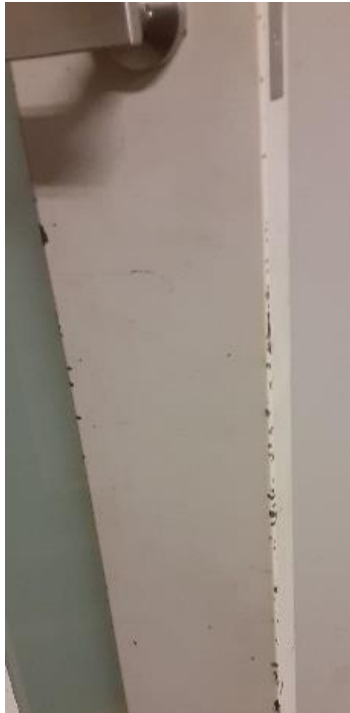
S 棟駐輪場扉
