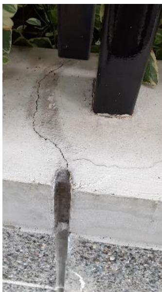
下馬通沿いの外構
