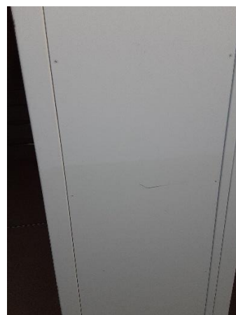
(3) 竣工前上塗り 竣工前の不良を上塗り
