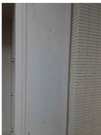
(1) 耐候性劣化 太陽、雨、風。下地は残
